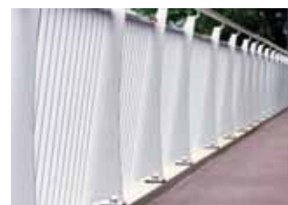
Voorhangend lamellenhekwerk met gelaserde baluster. Renovatieproject in Gorinchem
