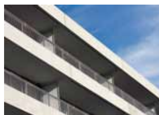
Spijlenhekwerk, fraai gecombineerd met gevelelementen. Spoorcomplex in Utrecht
