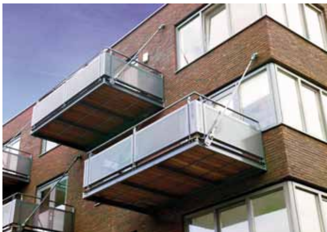
Balkonhekwerk voorzien van geperforeerde panelen
