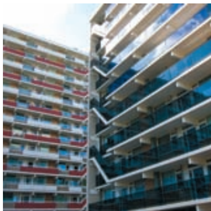
Arnhem, Kleefseplein. Grootschalig renovatieproject. Links op de foto het niet-gerevoveerde gedeelte, rechts de renovatie op moderne wijze
