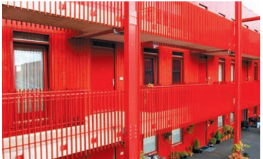
Rotterdam, Zaagmolenkade. Lamellenhek met moderne laserlichttechniek geproduceerd
