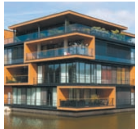
Rotterdam, De Lage Limiet. Toepassing van diverse hekwerken in een transparante en natuurlijke omgeving
